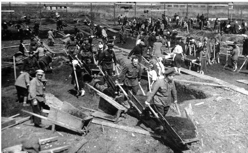
На строительстве железнодорожной ветки к ГРЭС II. 1943 год.
